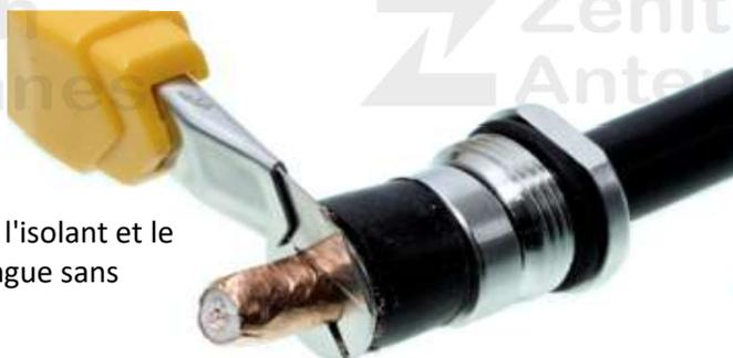
**8** Avec une cisaille adaptée(\*), couper l'âme centrale pour qu'elle dépasse de 6 mm
